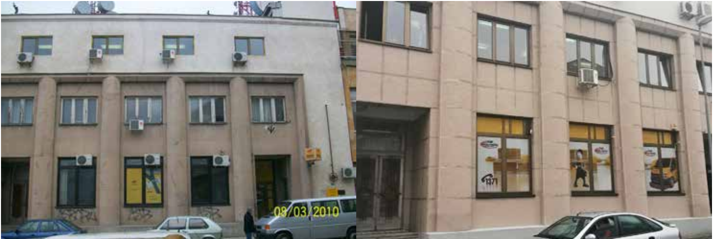
Пошта Бијељина прије и после реконструкције
